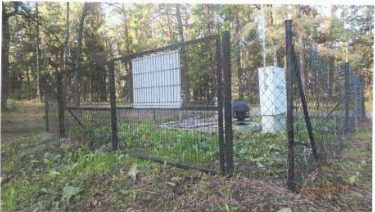
Zdj. 1 przepompownia przy drodze relacji Wejsuny - Niedźwiedzi Róg
