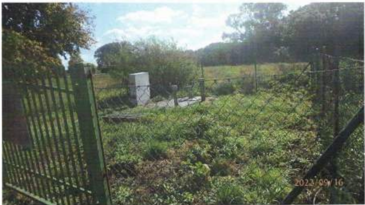
Zdj. 2 przepompownia Onufryjowo
